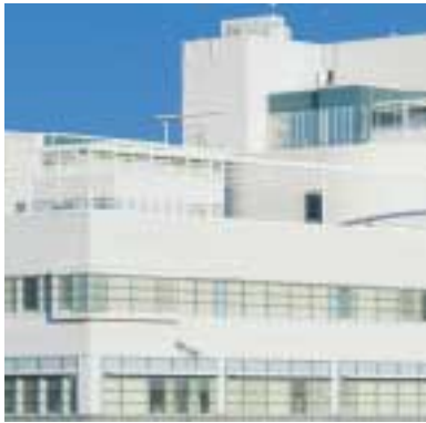
The office building at Piispanportti 12 near the Länsiväylä road in Espoo.
